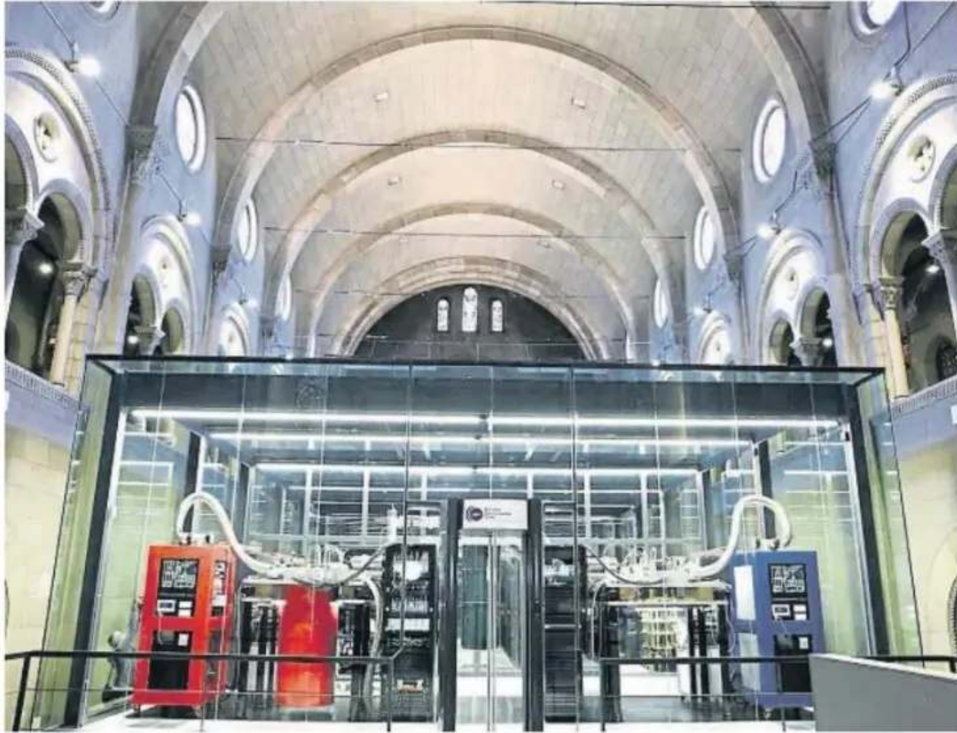
Los computadores cuánticos, en la capilla que albergó las cuatro primeras generaciones del MareNostrum
