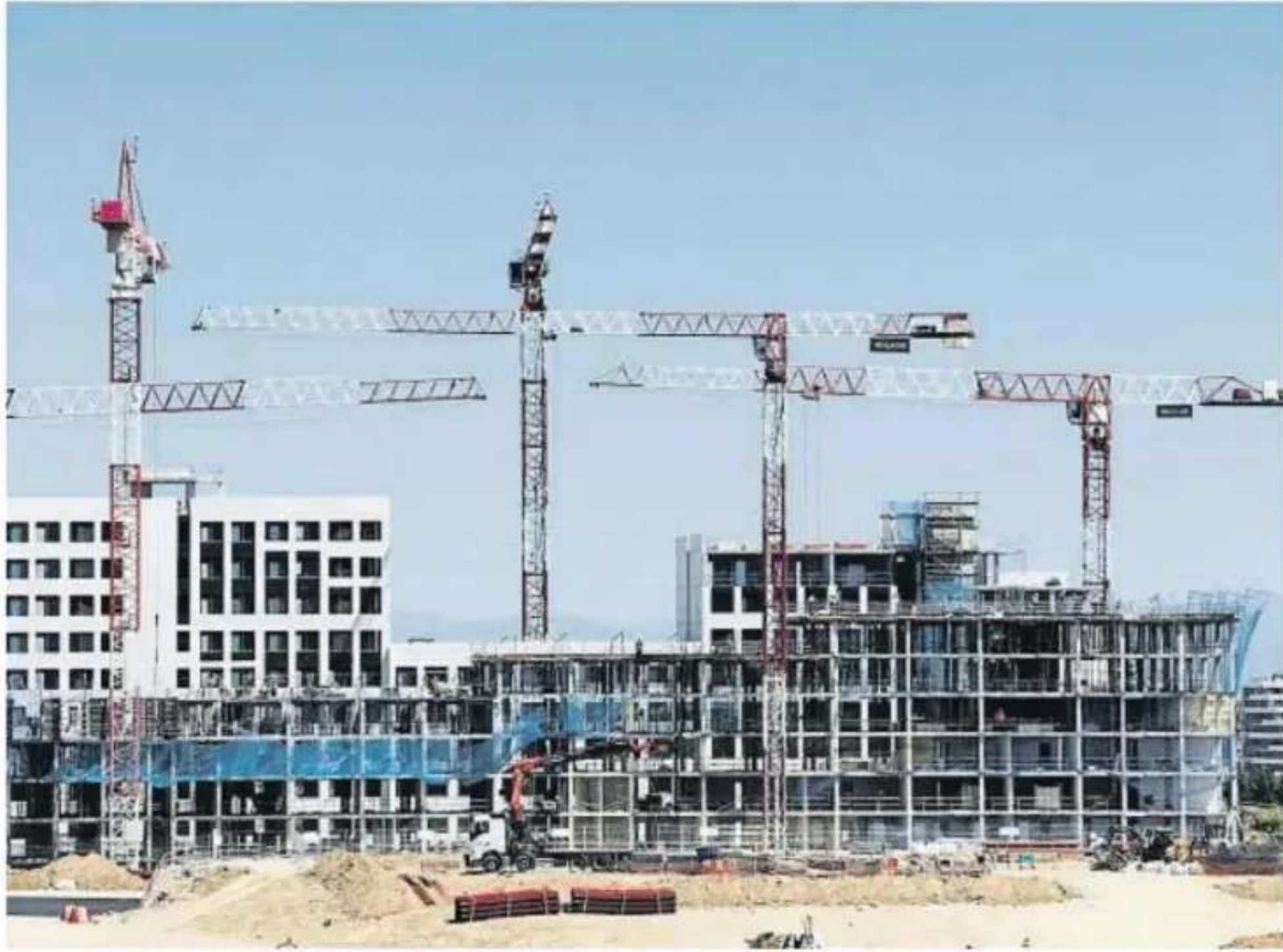
Construcción de viviendas de obra nueva en Madrid
