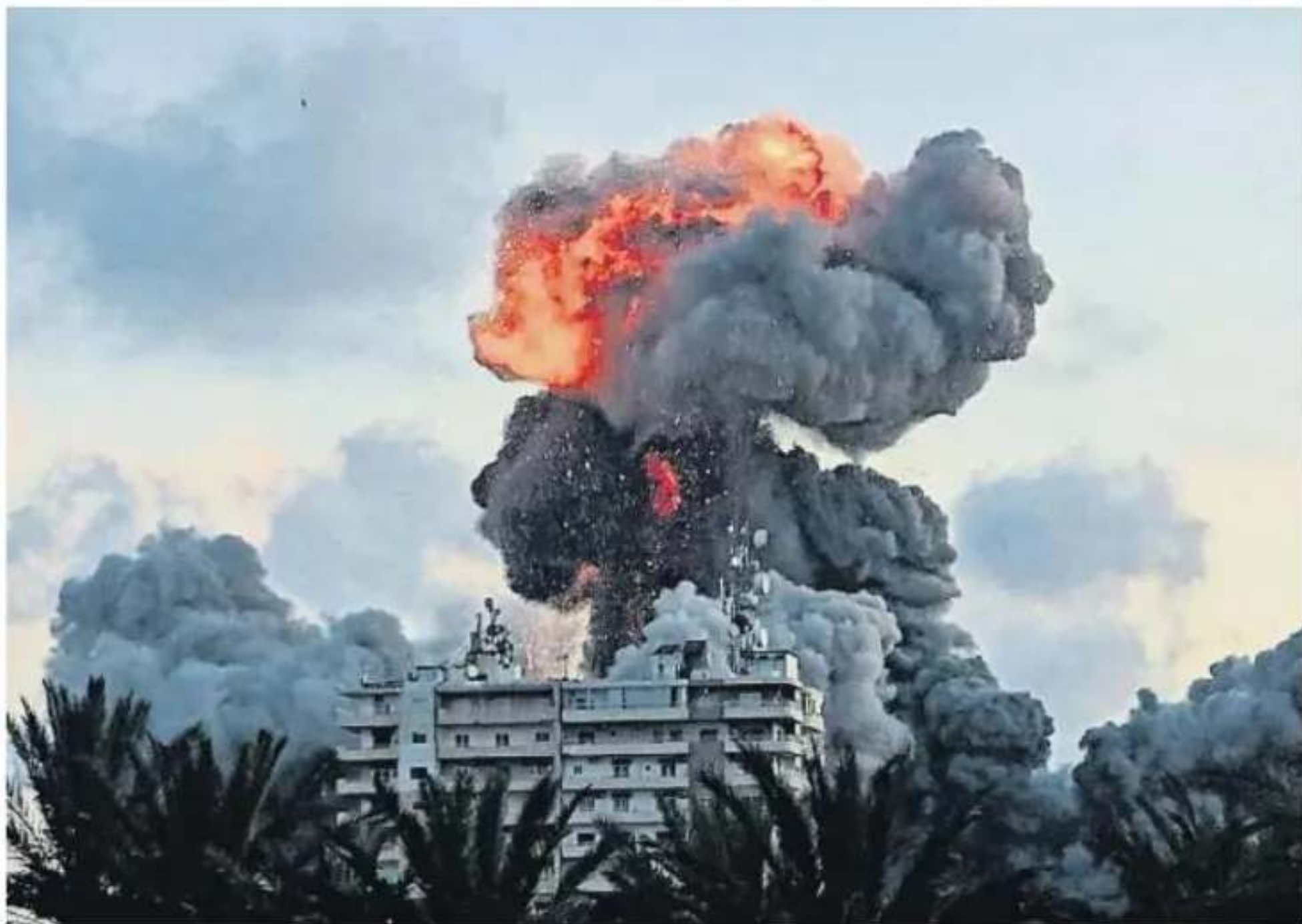
Edificio de Tiro, en el sur de Líbano, bombardeado ayer por el ejército israelí
